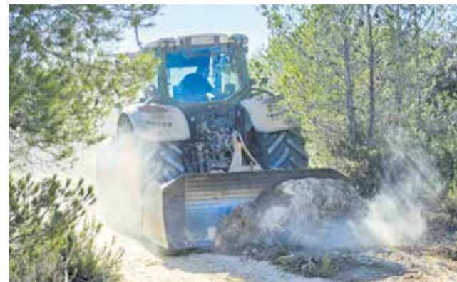
Acondicionamiento de un camino de Loriguilla. / EPDA
