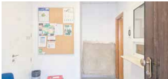
Trabajos de eliminación de humedades. / EPDA
