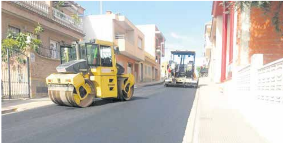
Trabajos de asfaltado en una calle de Riba-roja de Túria. / EPDA
