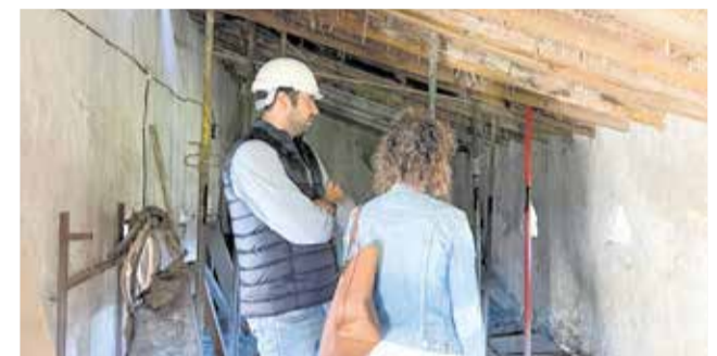
Visita del alcalde, Borja Gironés, a las obras. / EPDA
