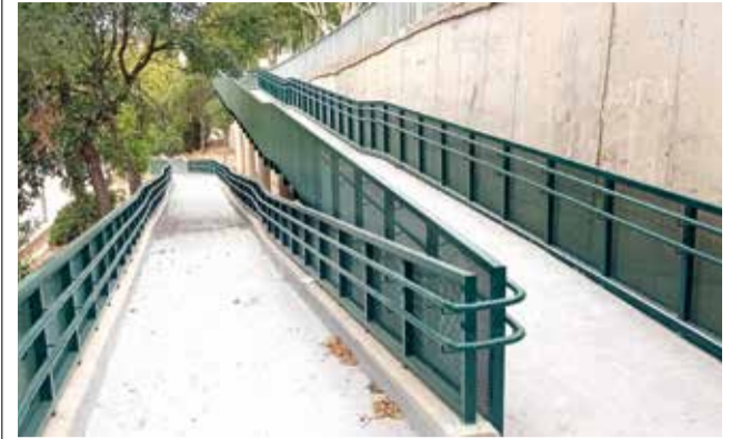
Construcción de la rampa. / EPDA
