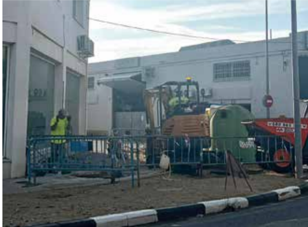
Les obres al polígon Jaume I de Benifaió. / EPDA
