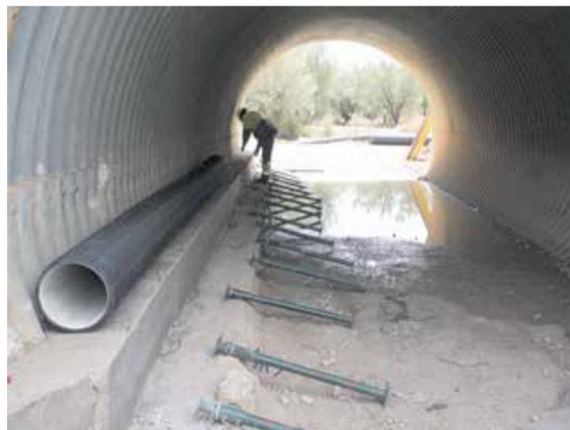
Obres per a l'abastiment d'aigua potable/ EPDA
