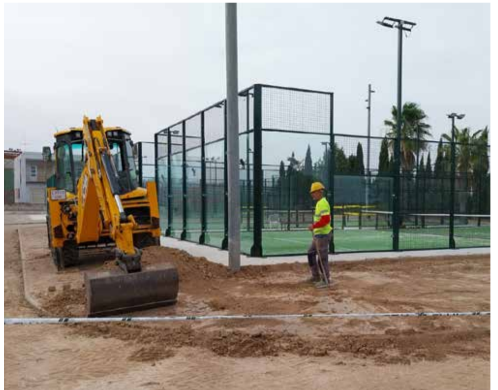
Adecuaciones en las pistas de pádel de Canet. / EPDA
