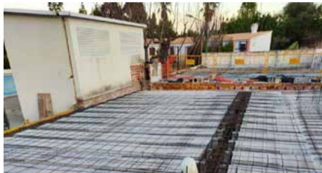
Rehabilitació del depòsit d'aigua municipal. / EPDA
