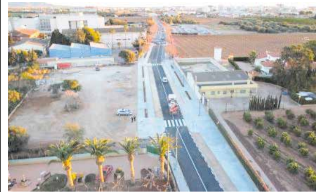
Remodelació de l'entorn de l'IES José Vilaplana. / EPDA
