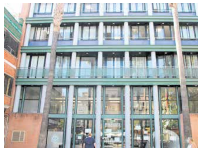
La fachada del ayuntamiento. / EPDA
