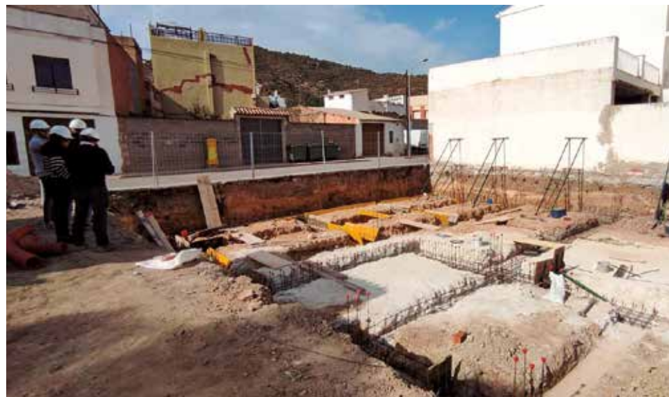
Obras del aulario del CRA La Serranía del Centro San Vicente Ferrer. / EPDA
