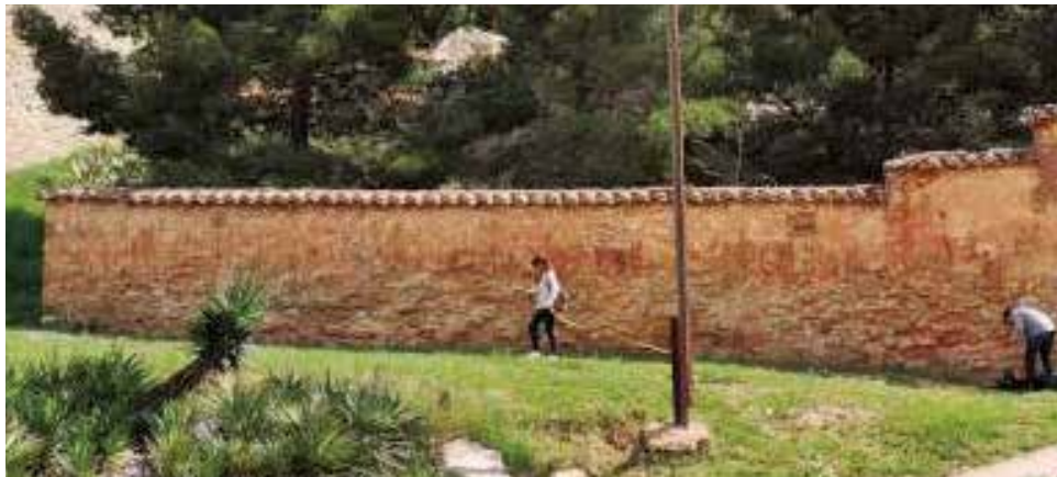
Trabajos de rehabilitación del antiguo cementerio de Titaguas. / EPDA
