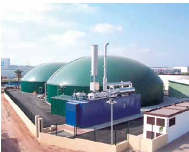
Planta de biogás en la Vall d'Uixó (Castellón). / EFE
