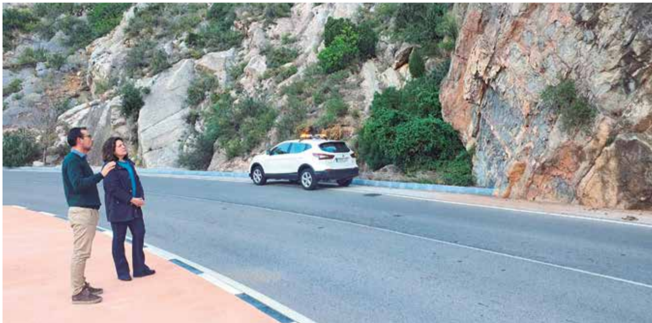
Visita de la directora general d'Infraestructures, M. José Martínez Ruzafa, a la CV-230. / EPDA
