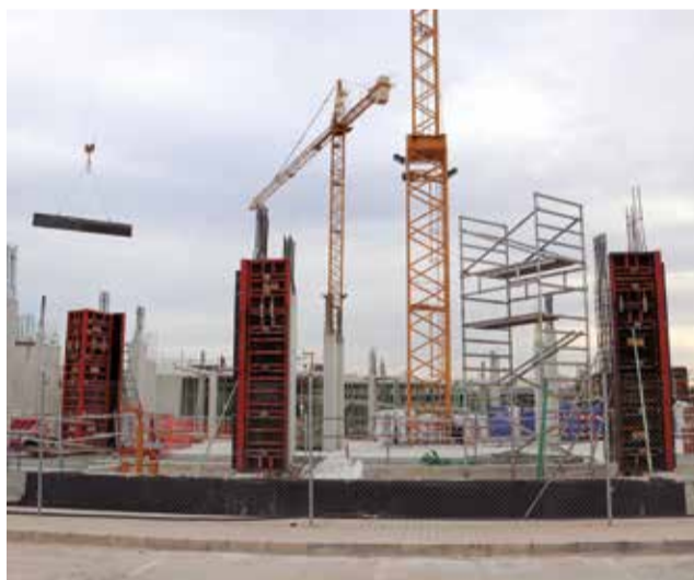
Estado de las obras del hotel. / BORJA PEDRÓS
