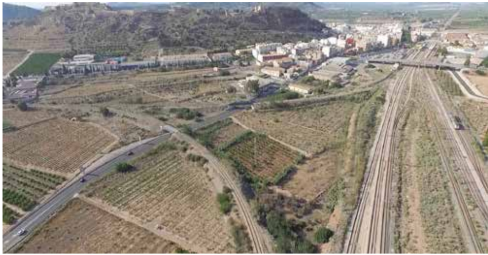
Vista de la línea ferroviaria que cruza Sagunt. / EPDA
