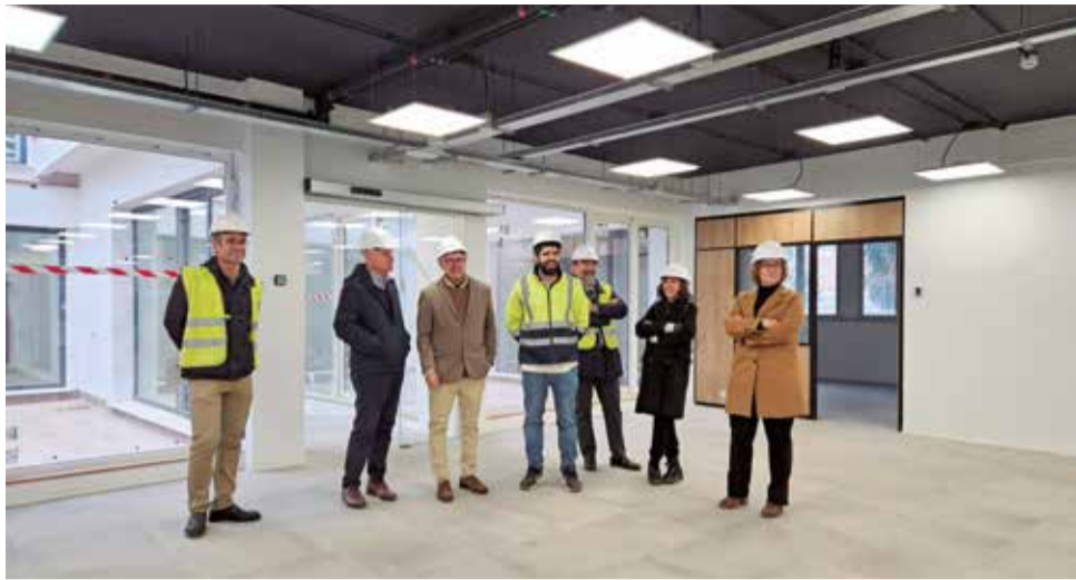
Visita a las obras de la Casa de la Cultura de l'Eliana. / EPDA
