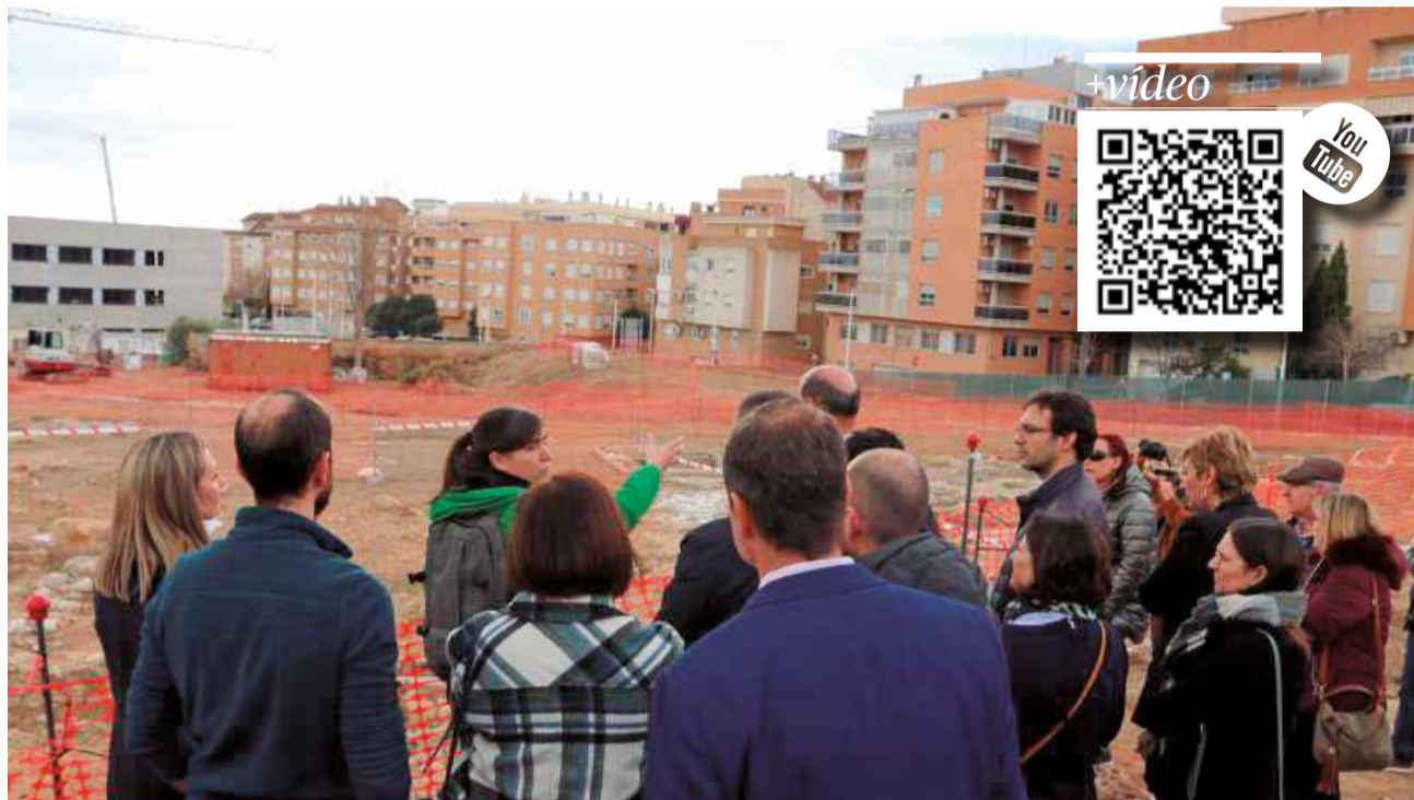
Visita a las obras del nuevo CEIP nº3 de Lliria. / JUDITH CELMA
