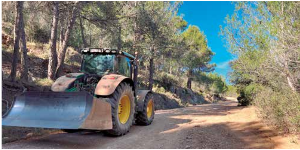
Treballs de condicionament en la Pista del Llentiscler de Serra. / EPDA
