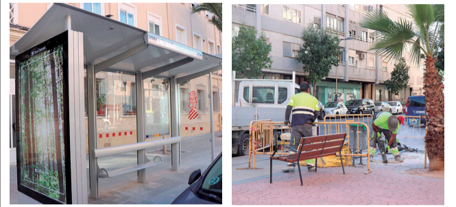
Instalación de las nuevas paradas de bus. / EPDA
