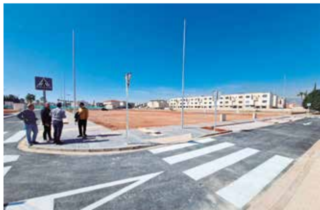
Obertura dels nous vials a Nules. / EPDA
