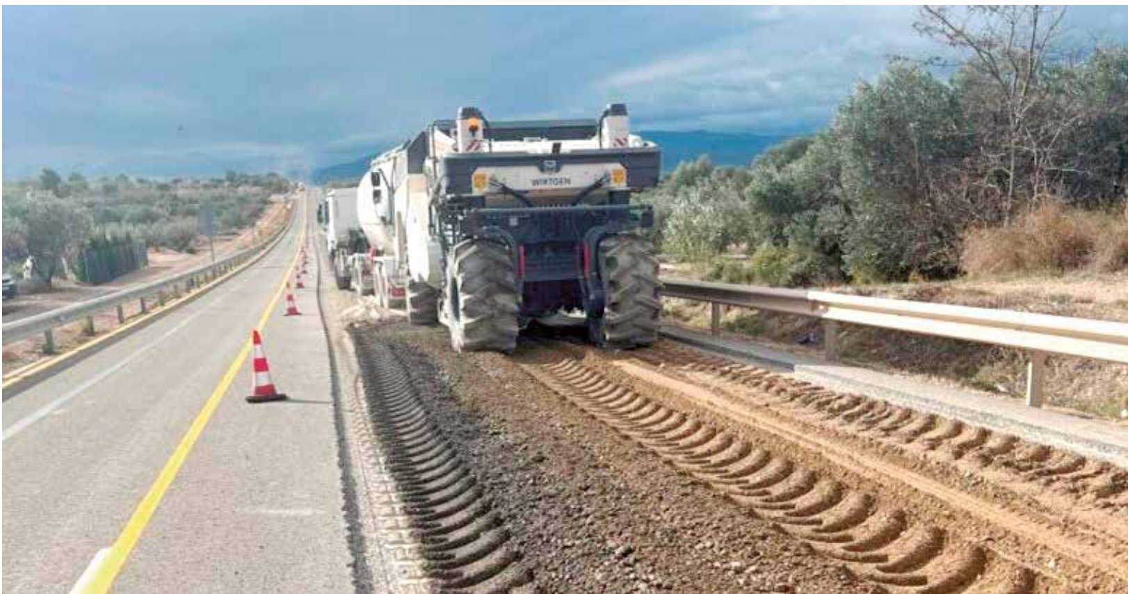
Obras de mejora en la carretera CV-395 en el término municipal de Villar del Arzobispo. / EPDA
