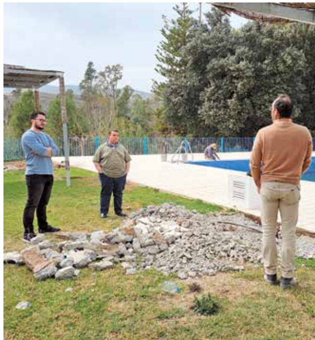
Visita a las obras de la piscina de Pedralba. / EPDA
