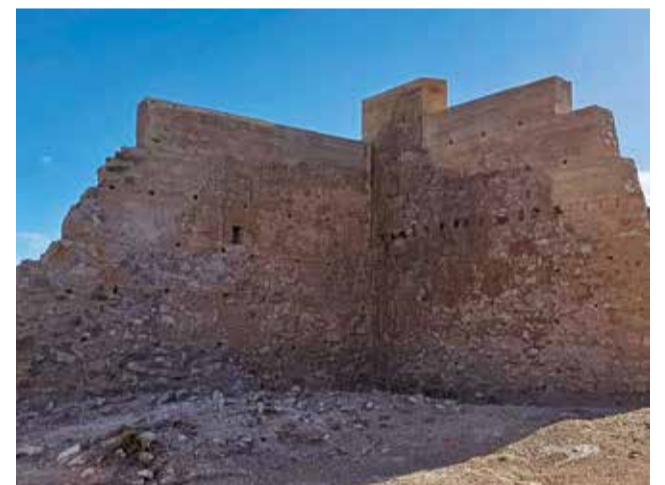
El Castillo de Chera en su proceso de restauración. / EPDA
