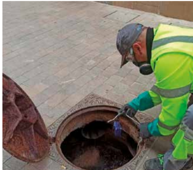
Tratamiento directo en el alcantarillado. / EPDA
