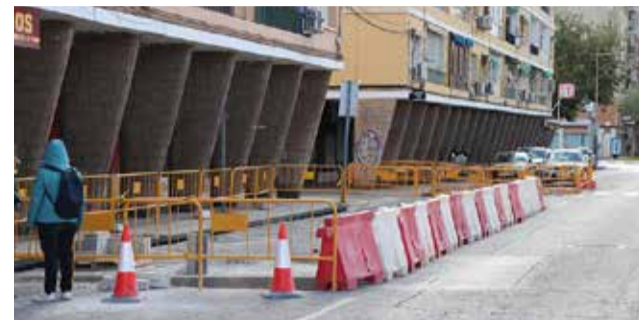
Actuaciones en la avenida. / EPDA
