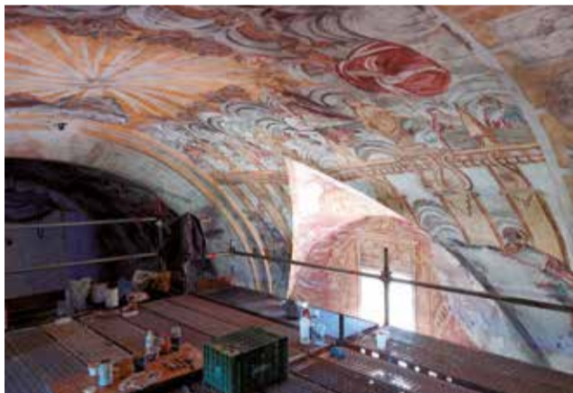
Restauración del interior de la iglesia. / EPDA
