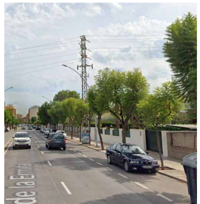
Línia de mitja tensió del carrer de l'Ermita. / EPDA
