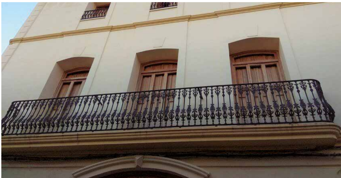
Façana de la Casa de l'Advocat de Riba-roja de Túria. / EPDA
