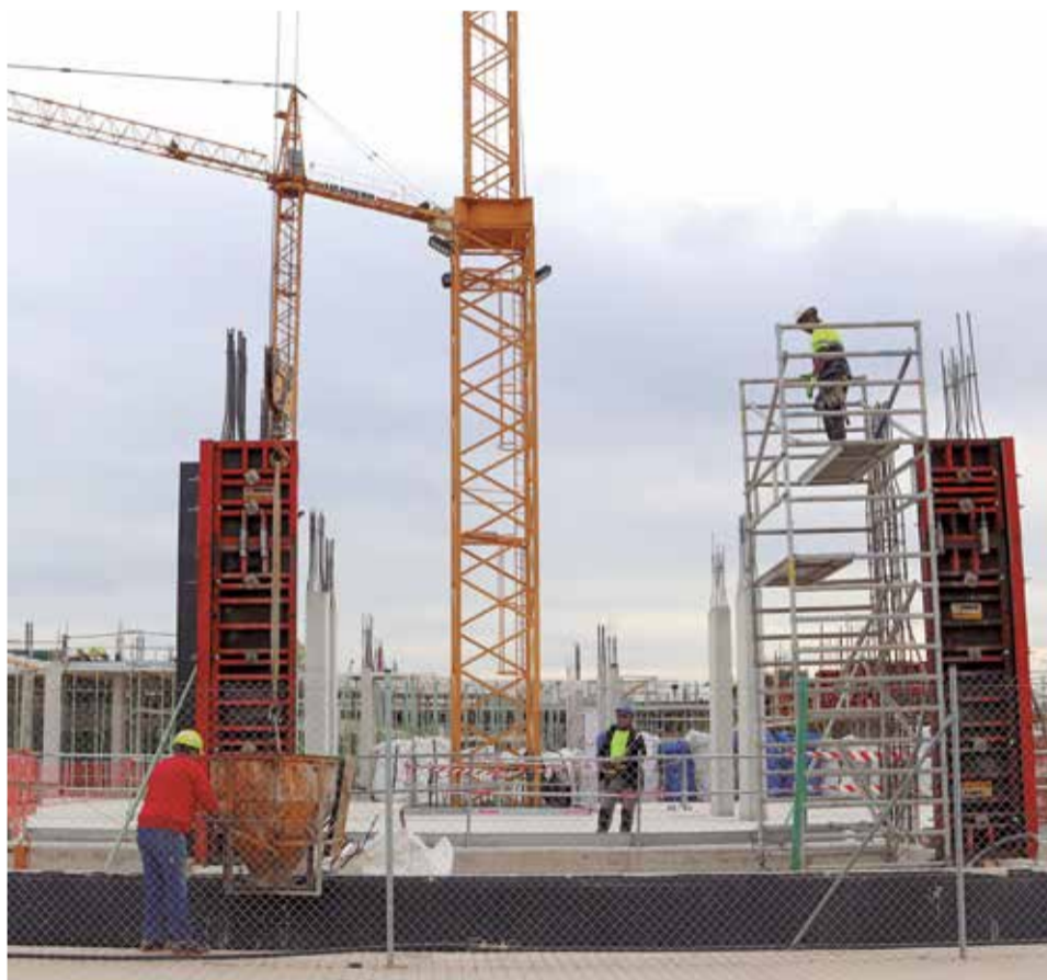
Construcción de una vivienda en el Port de Sagunt. / BORJA PEDRÓS
