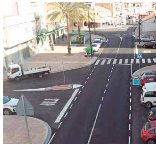
La carretera N-332 a su paso por Favara. / EPDA
