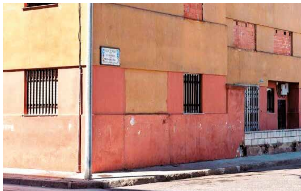
Bloque de viviendas públicas en el Raval, Algemesí. / EPDA
