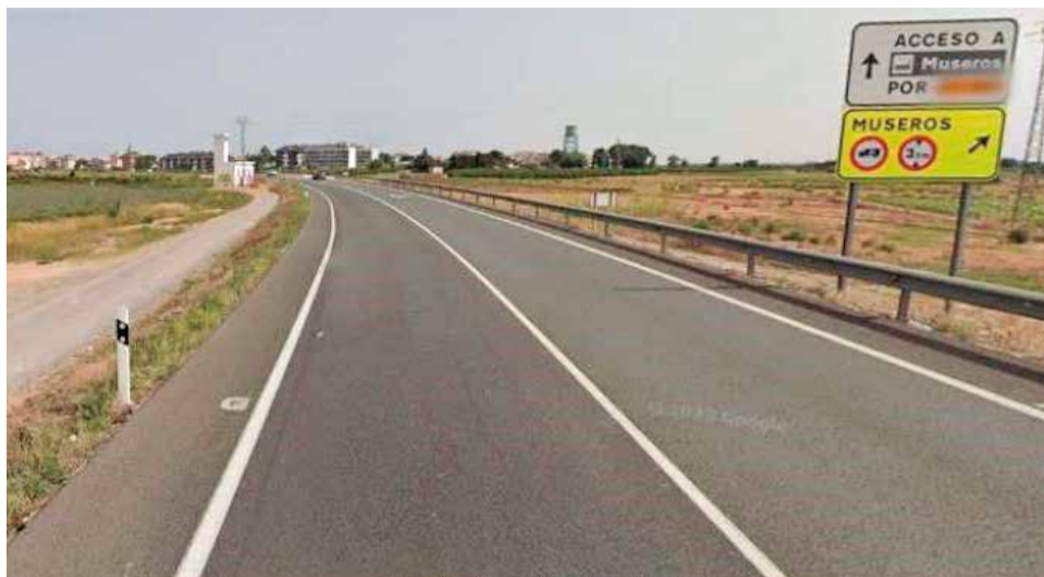
Les obres de la CV-32 entre Museros y Massamagrell, a punt de licitació. / EPDA
