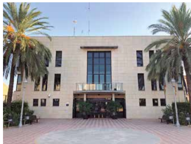
La fachada del ayuntamiento. / EPDA
