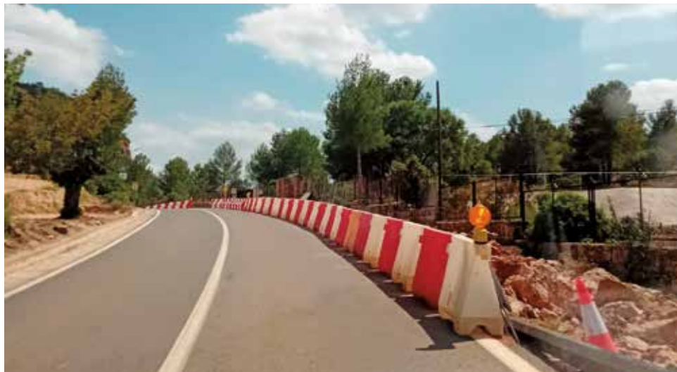
Trabajos en la CV-394 en Chulilla. / EPDA
