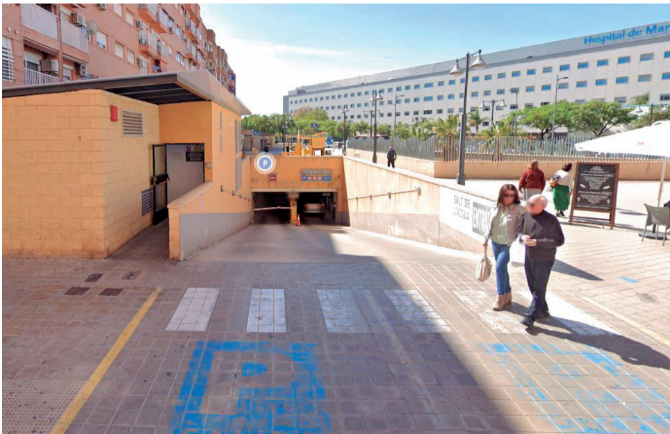
El parking de la calle San Cayetano de Manises. / EPDA
