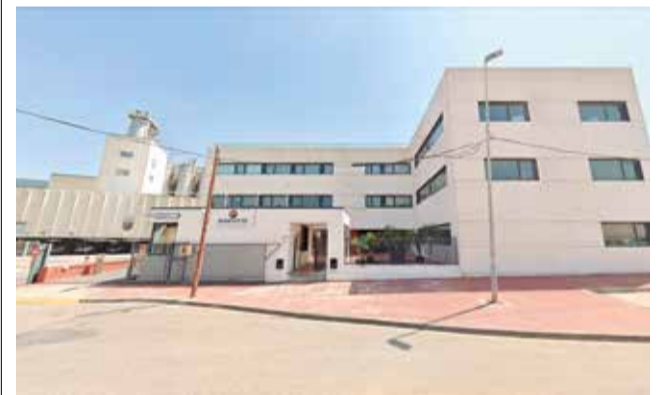
Empresa de Benifaió beneficiaria. / EPDA
