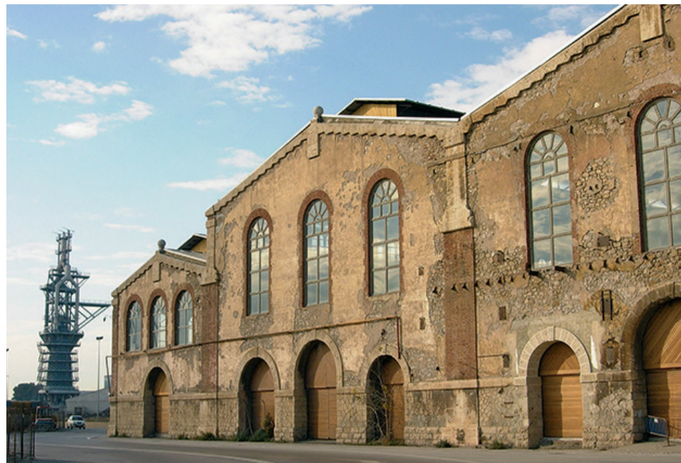
Nave de talleres del Port de Sagunt y, al fondo, el Alto Horno. / EPDA
