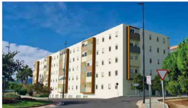
Previsió d'edifici rehabilitat. / EPDA
