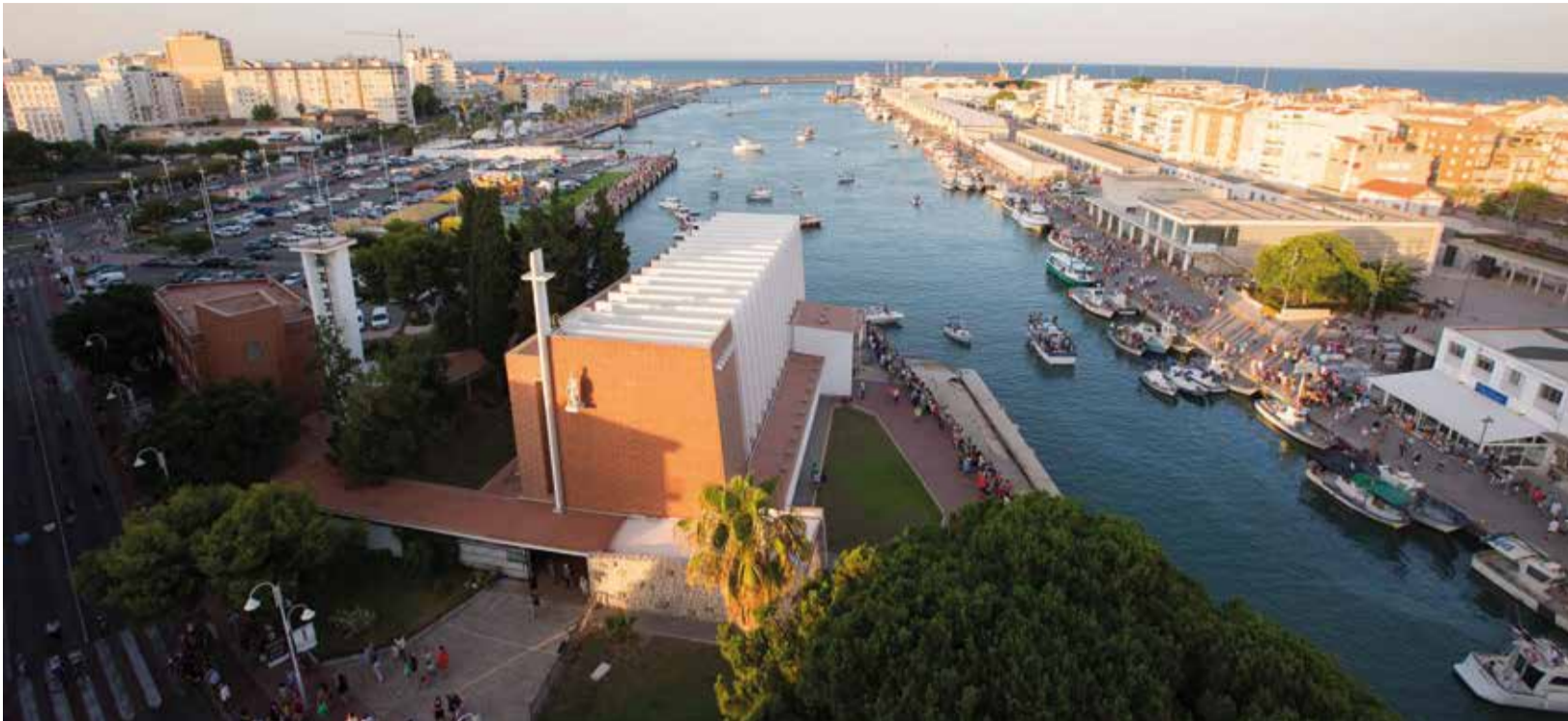
L'edifici religiós espera l'aprovació de la declaració. / EPDA
