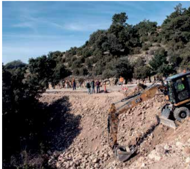
Obres de millora en la CV-111. / EPDA
