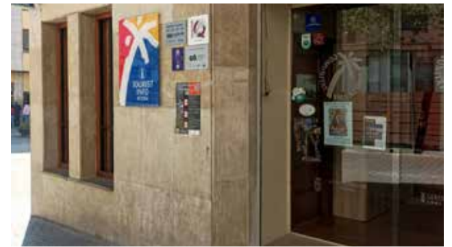
Uno de los bucles se ha instalado en la Tourist Info. / EPDA
