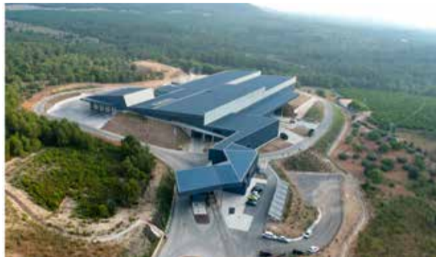
Planta de tratamiento de residuos. / EPDA
