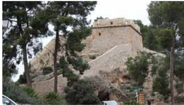
Último tramo restaurado en 2022. / EPDA
