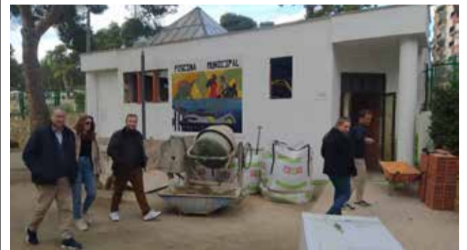
En un mes terminarán las obras. / EPDA
