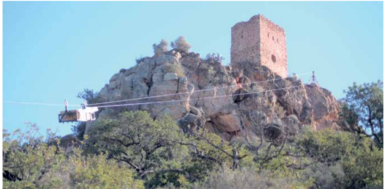
Trabajos en la 'Torre de l'Agüelet' de Almenara. / EPDA
