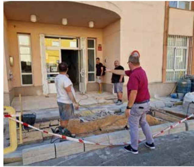
Obres de millora d'accessibilitat del Centre Social. / EPDA
