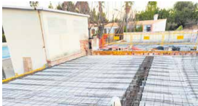
Rehabilitació del depòsit d'aigua municipal. / EPDA
