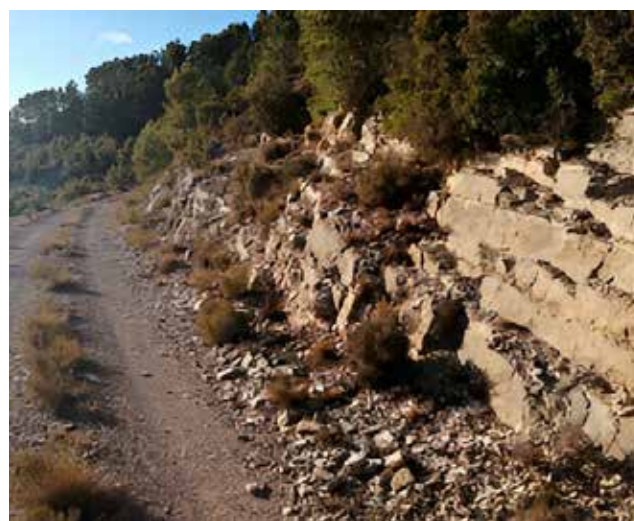
Estado del camino antes de los trabajos. / EPDA
