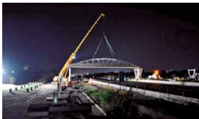
La instal·lació de la nova passarel·la. / EPDA
