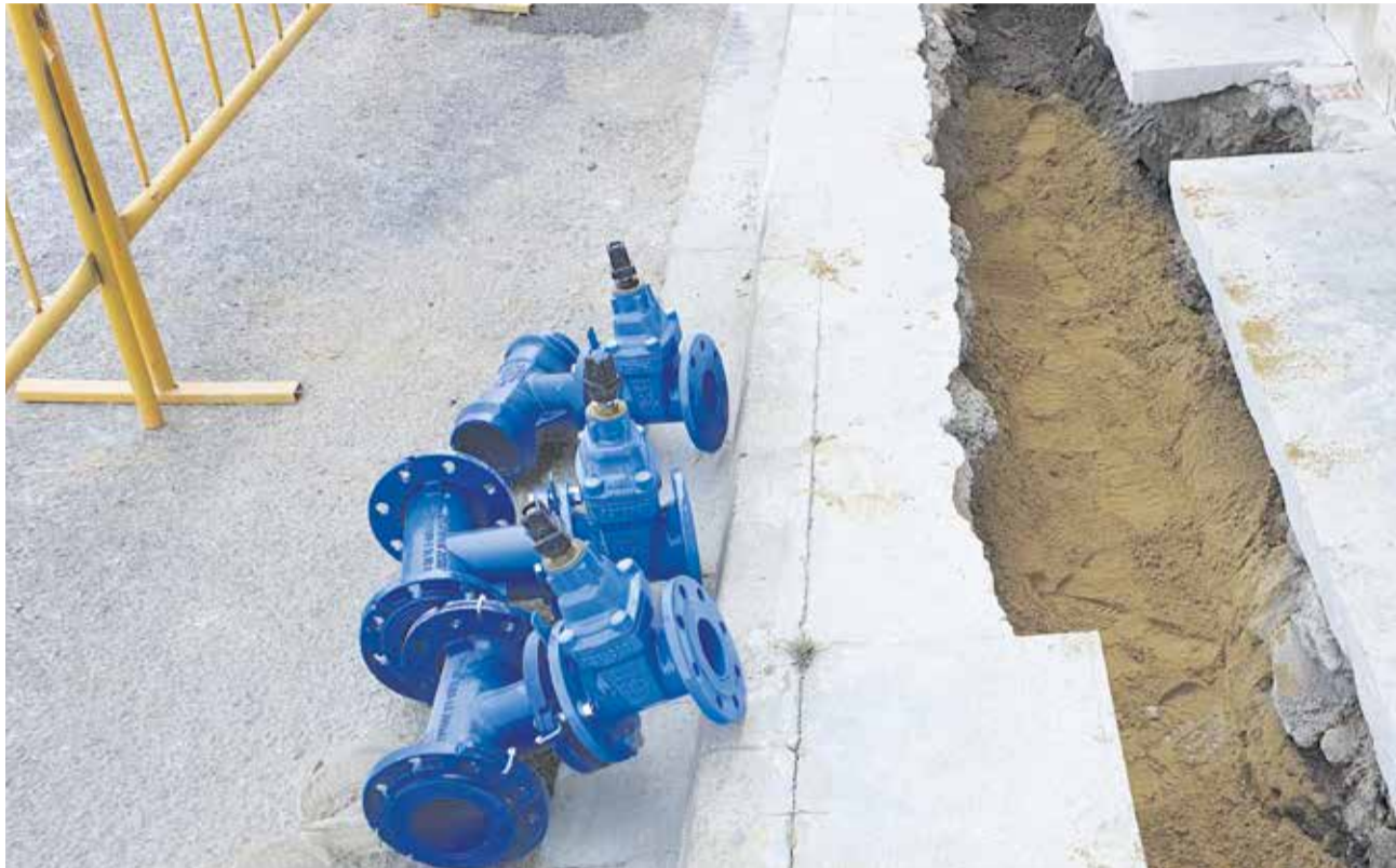
Un dels clavegueram del municipi durant les obres del projecte / AUTOR FOTO
