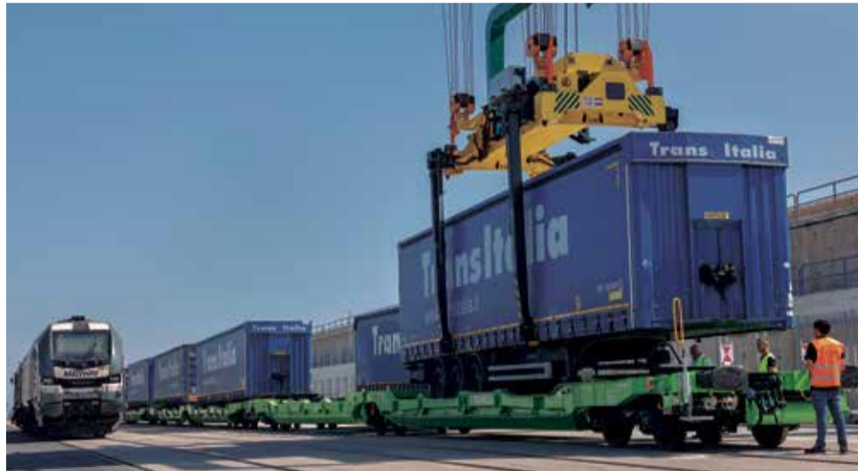
Arranque de la nueva autopista ferroviaria Madrid - Valencia. / EPDA
