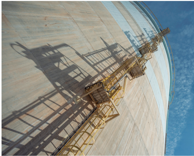
Instalaciones de Saggas en la comarca. / SAGGAS
