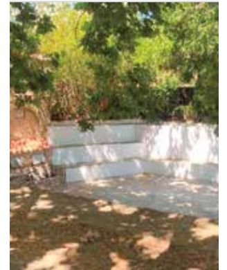
Fuente de la Mina. / EPDA
