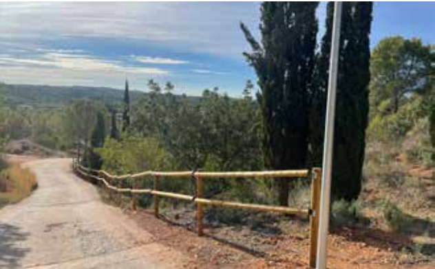
Camino de acceso al Mirador de la Torreta. / EPDA
