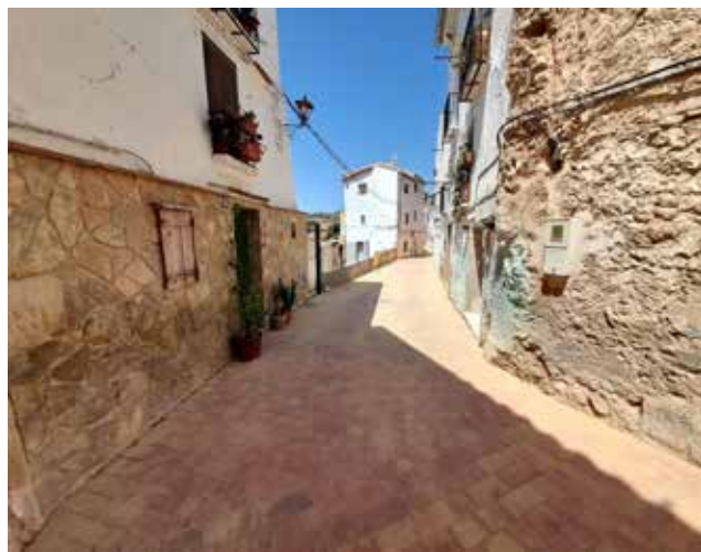
Estado de la calle Murtera tras los trabajos. / EPDA
