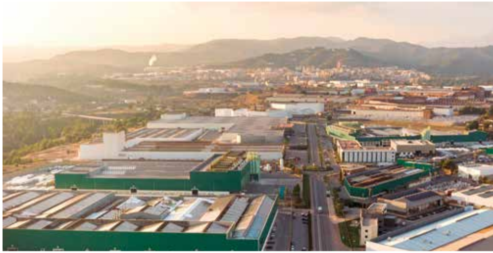
Vista aèria d'una zona industrial del municipi de l'Alcora. / EPDA
