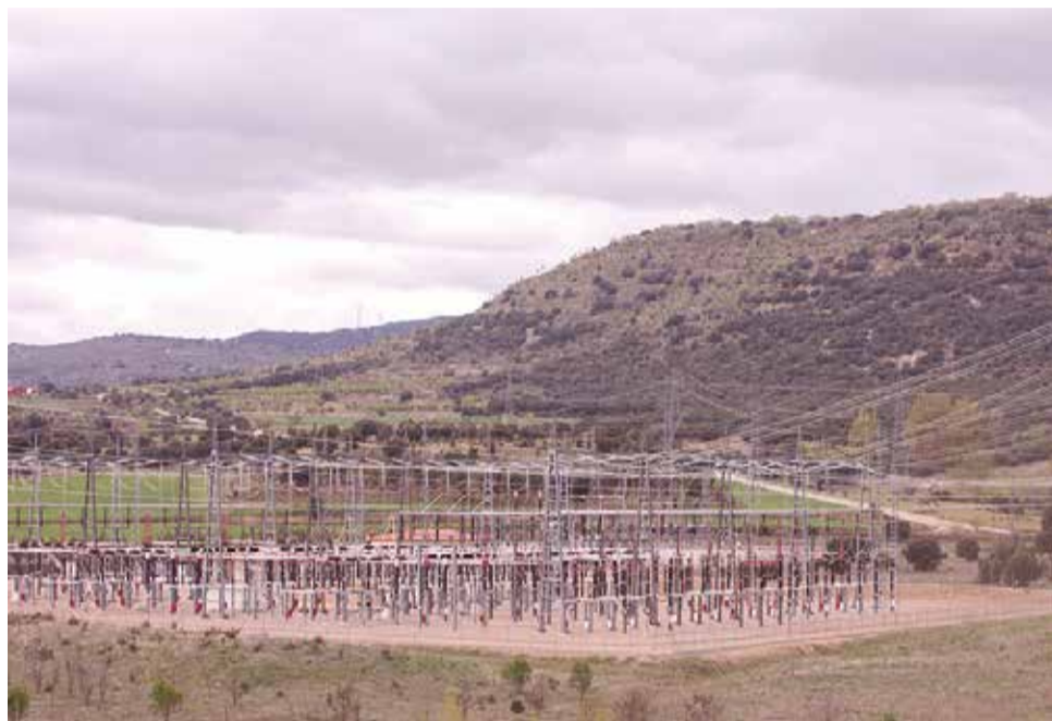
Subestació elèctrica de Freiximeno a Morella. / EPDA
