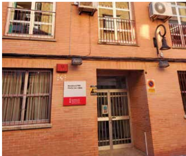
La façana de l'actual residència de majors. / EPDA
