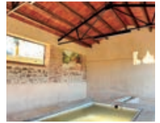
Lavadero de Peñalba. / EPDA
