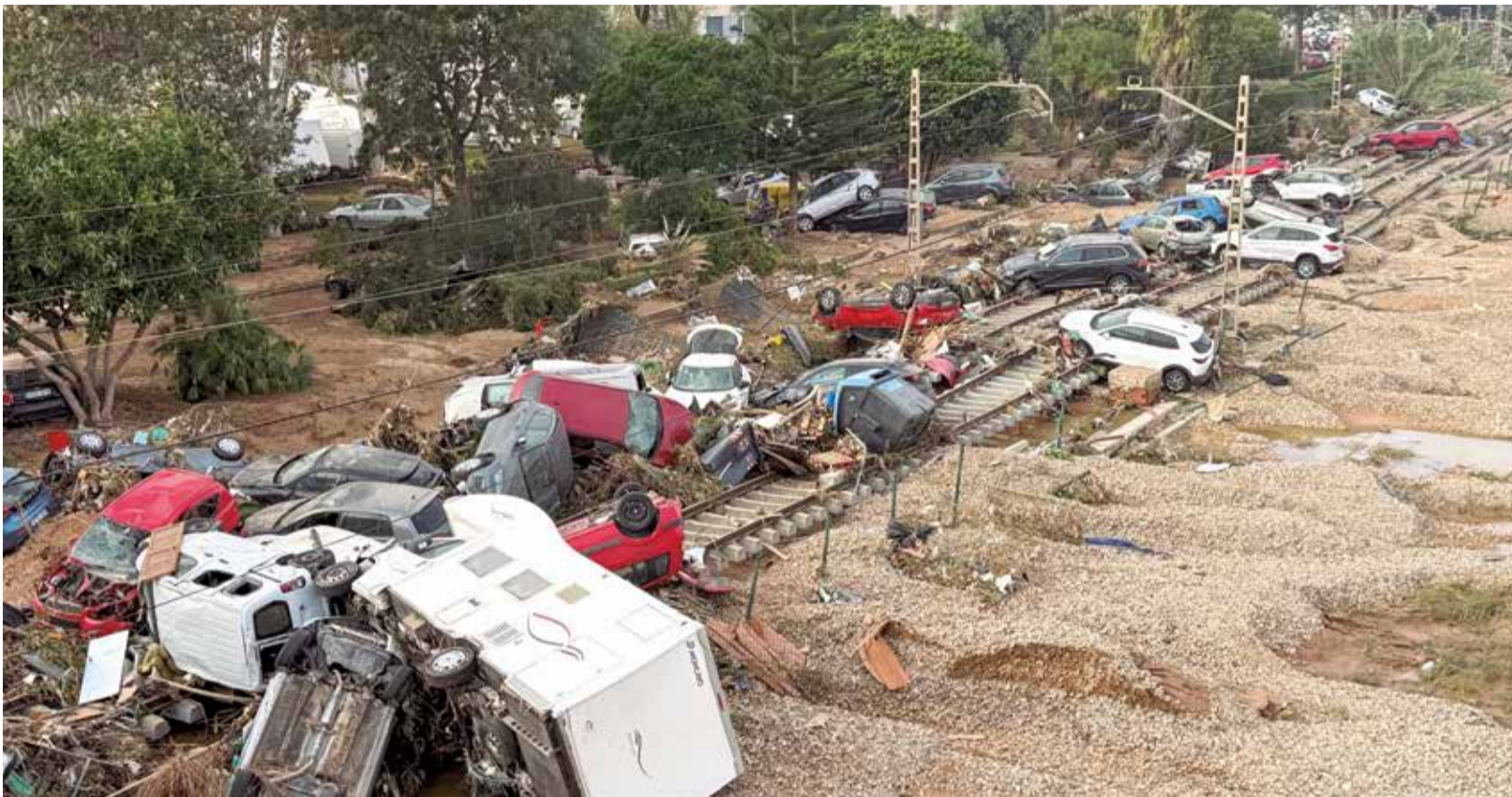
Estado de las vías de la línea C3 tras el paso de la DANA del pasado 29 de octubre. / EPDA
