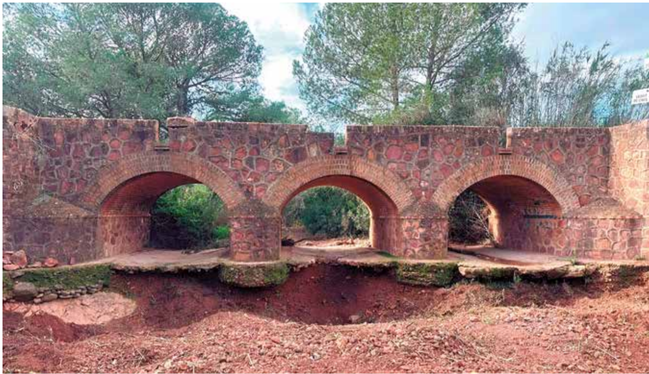
Pont del camí d'Escales sobre la rambla de Cerverola. / EPDA
