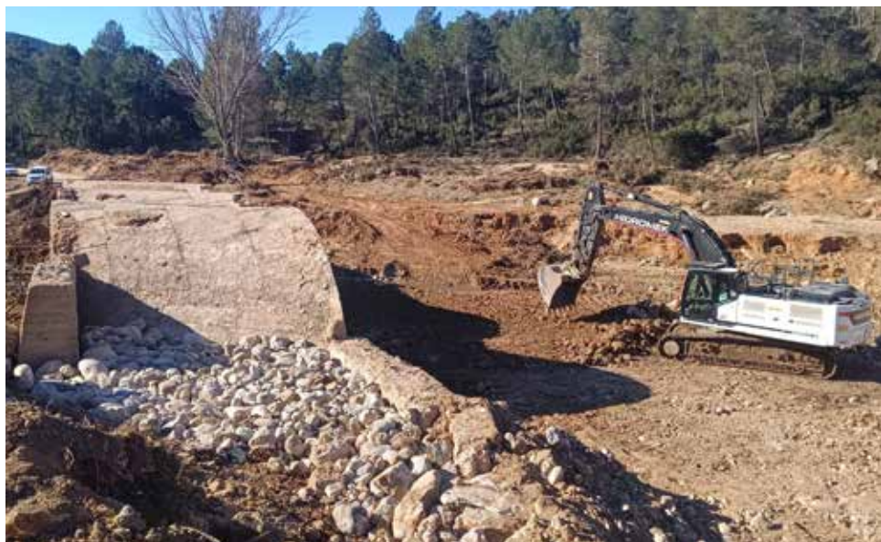
Trabajos de reconstrucción en Chera y Requena. / EPDA
