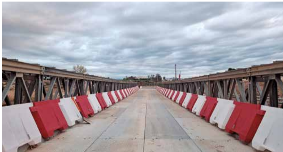
Nuevo puente provisional de conexión con la zona norte de Riba-roja. / EPDA
