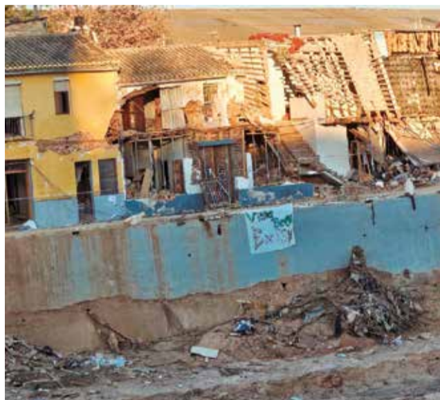
Viviendas derruidas en Picanya. / EPDA
