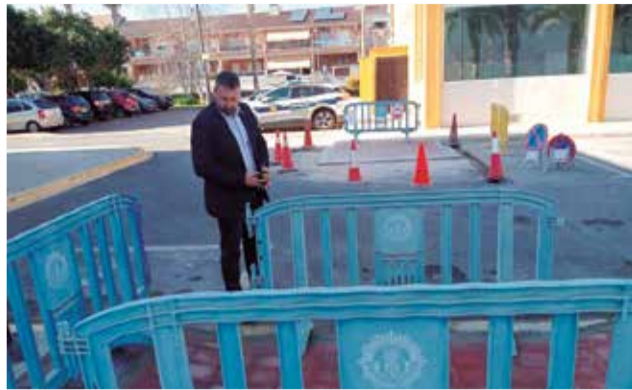
El regidor Eduardo Almor visita les obres. / EPDA
