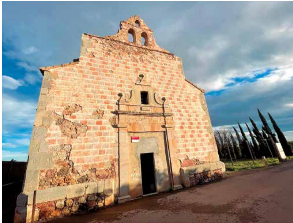
Façana de l'ermita de Benicalaf (Benavites). / BORJA PEDRÓS
