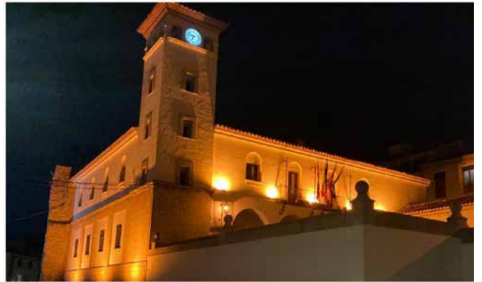
Aspecto con la nueva iluminación. / EPDA
