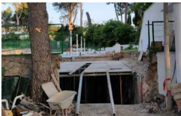
Instalación del encofrado. / EPDA
