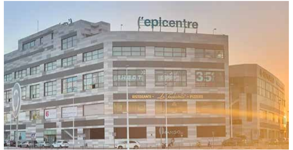
Centro Comercial Lepicentre. / EPDA
