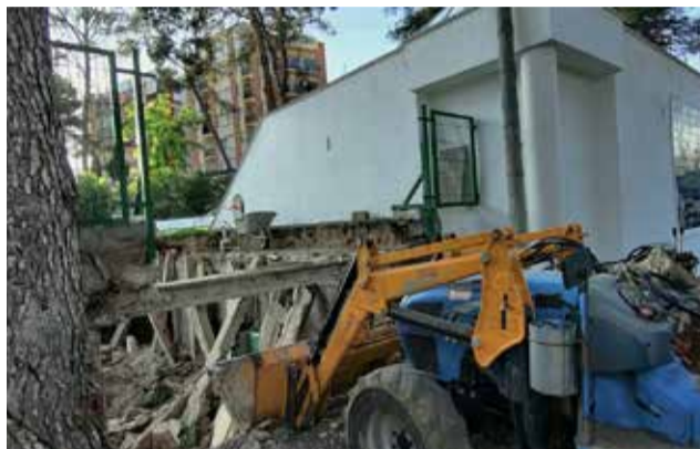
Desescombro del derrumbe. / EPDA
