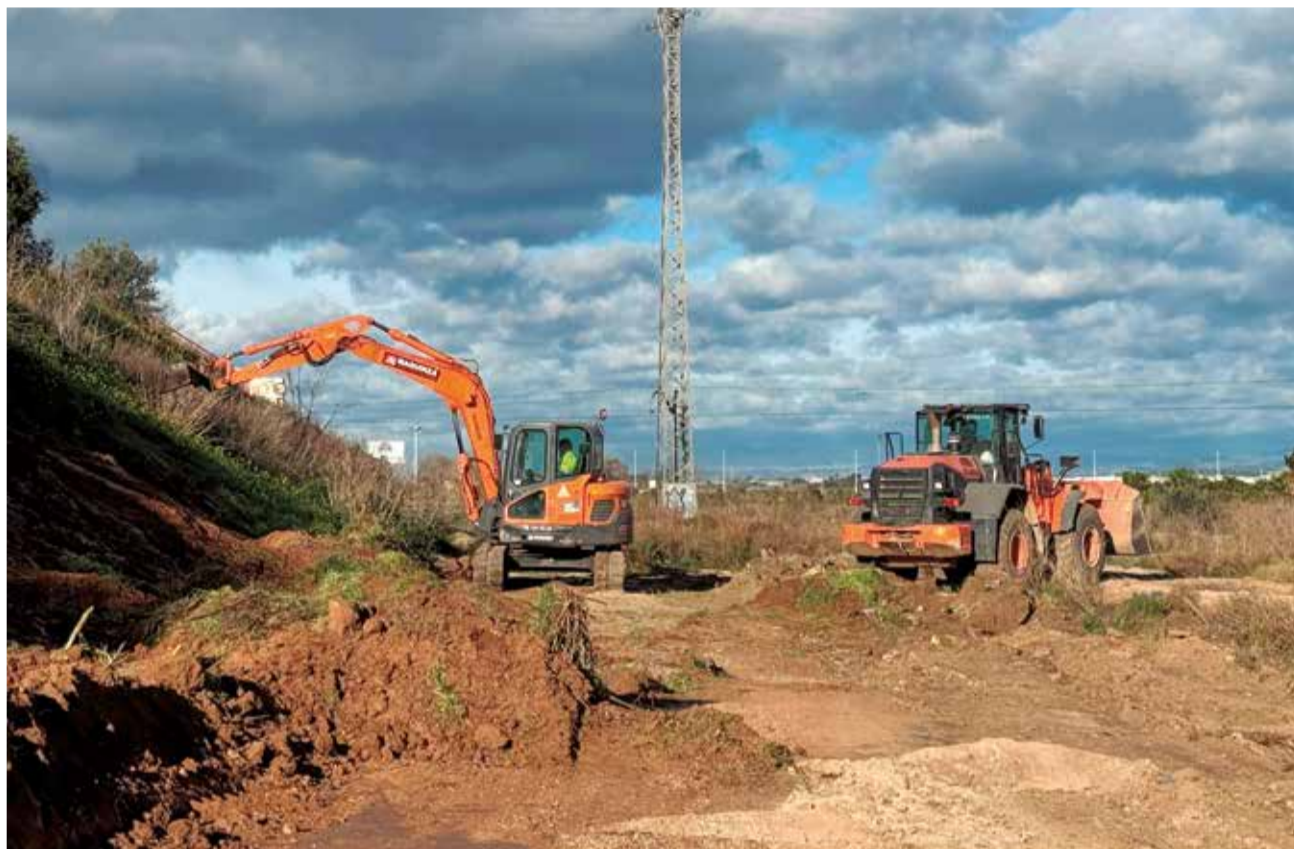
L'inici de les obres sobre el terreny. / EPDA
